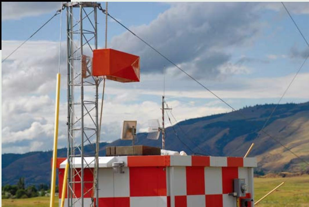
直引导，安全地指引飞行员在能见度低至1/2英里（800米）的情况下飞到最低200英尺离地高（AGL）。使得在这些机场和地区的飞行变得更可行更安全。”
