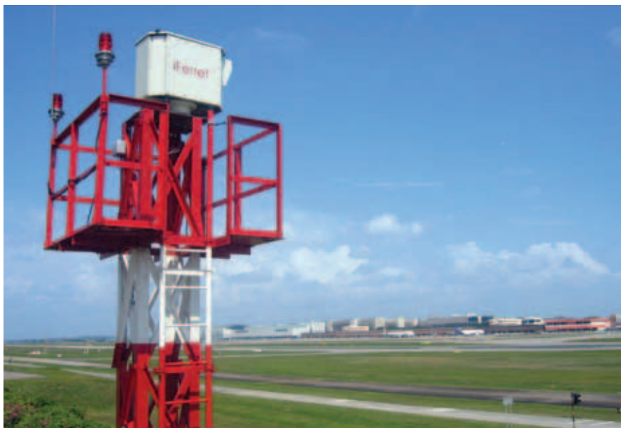
Strattech Systems公司的iFerret是一个光电系统，可以用来监控跑道、滑行道和停机坪上的FOD。
